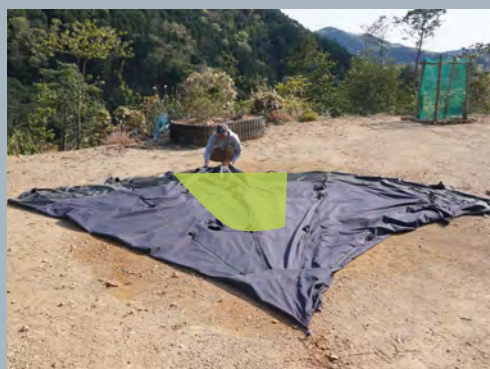
9.頂点を起点に裾を重ねるように半分に折り畳む(この時、9角形なので、角はズレます。)
