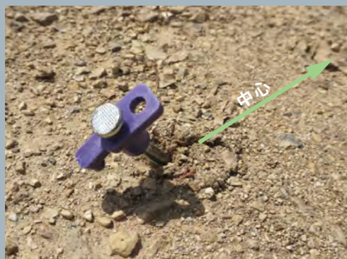
3-2.ペグは中心とは反対方向に少し倒すと抜けにくくなります。
