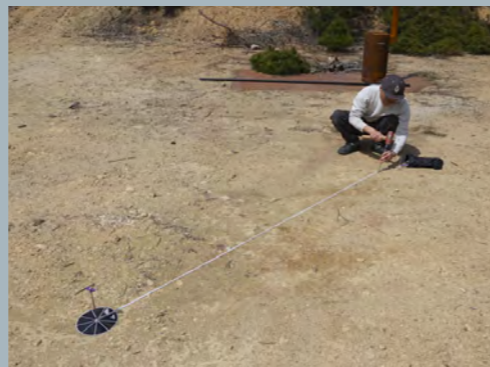
3-1.同梱されているガイドとロープを使用し、ペグを地面に固定していく(9カ所)
